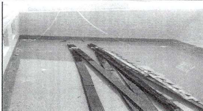
Foto 2: SUSTITUCION DE LAMINA
