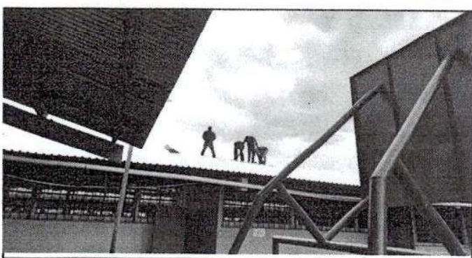
Foto 6: SUSTITUCION DE LAMINA
